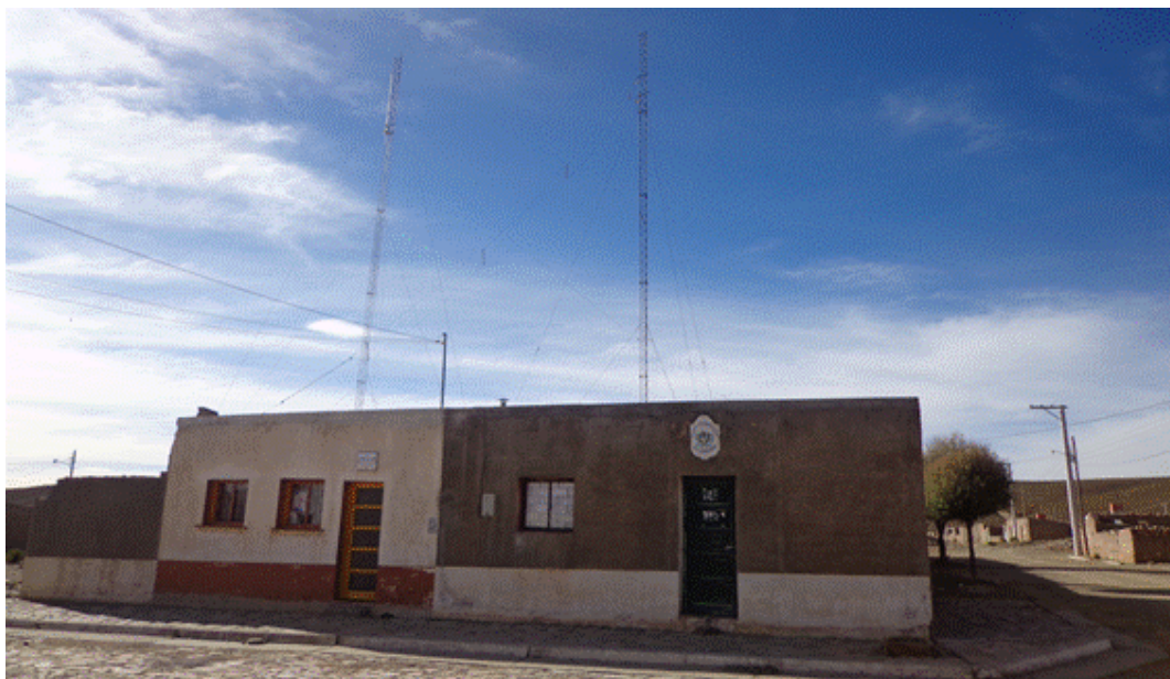
Figura 9: Puesto de Salud y Destacamento policial con antenas de Radiocomunicación VHF/UHF (El Condor – Dpto. Yavi)
